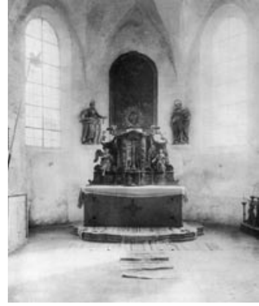
Chorraum der Pfarrkirche Günz mit seiner schlichten Ausstattung vor dem Umbau, 1902.
